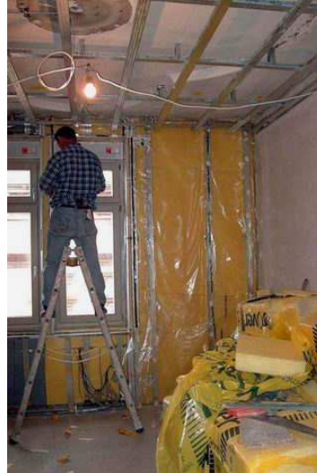
Bild 1. Innendämmung: mit Styropor(NEOPOR) und Mineralwolle(ISOVER) (Eigene Photos)
