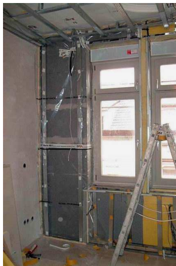
Bild 1. Innendämmung: mit Styropor(NEOPOR) und Mineralwolle(ISOVER) (Eigene Photos)
