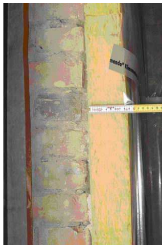
Bild 3 – Die richtige Dämmstärke (Eigene Photos und Zeichnungen)
